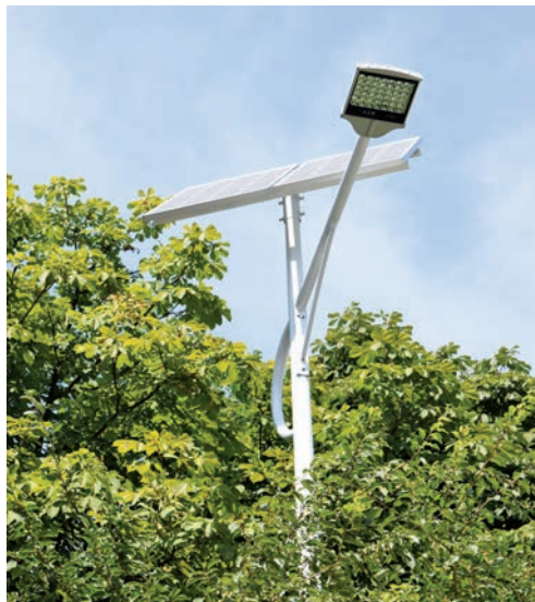
Sistemul de iluminat public din satele Ermoclia, Feștețița și Popeasca din raionul Ștefan Vodă
