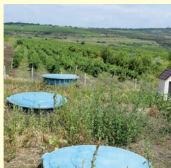
Sistemul de management al apei din satul Sireți, raionul Strășeni
