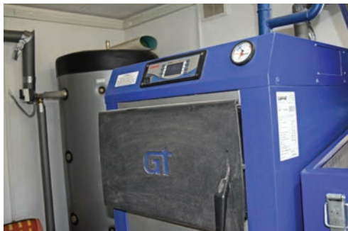
Cazan pe biomasă, instalat la școala primară – grădiniță din satul Ruseștii Vechi, raionul Ialoveni
